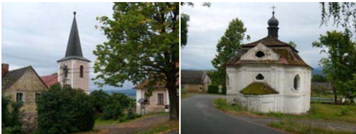
Obr. 2.2.29: Dlažov. Obr. 2.2.30: Miletice. Dominantou Dlažova je kostel sv. Antonína Paduánského. Nejvýznamnější stavbou osady Miletice, místní části Dlažova, je kaple svatého Jana Nepomuckého na návsi. (Foto: Jiří Kupka)
